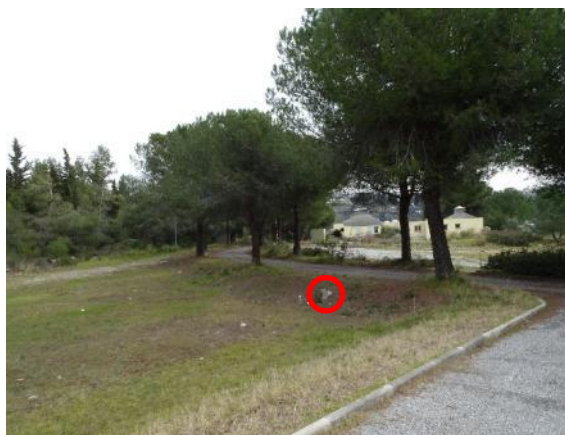
14. Ouvrages hydrauliques sous la voie d'accès
