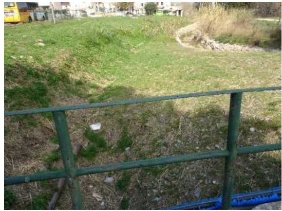
4. Canal des Iscles et canal de décharge au Sud de l'aire d'étude (au niveau du franchissement par la piste cyclable)
