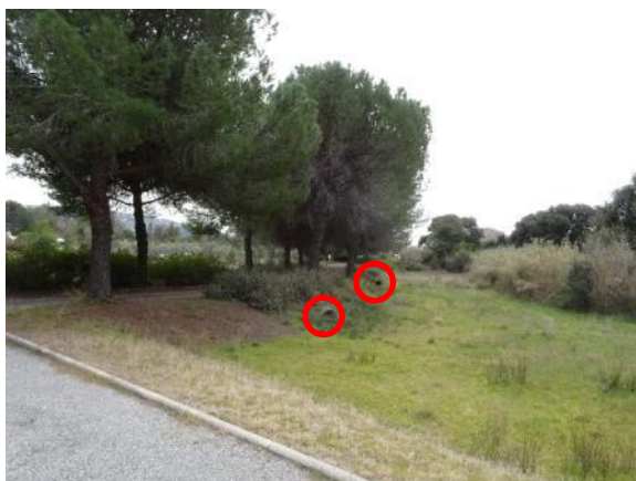
13. Ouvrages hydrauliques sous la voie d'accès
