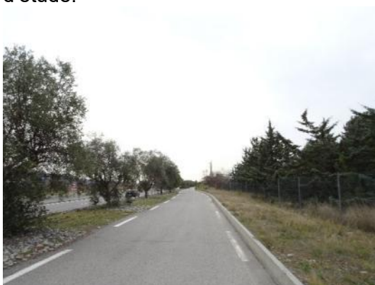
9. au droit du secteur Nord
