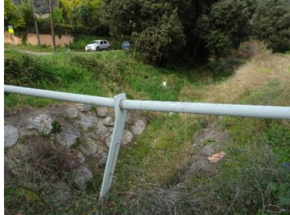
2. Canal des Iscles au niveau du pont d'accès à l'ancien CREAT
