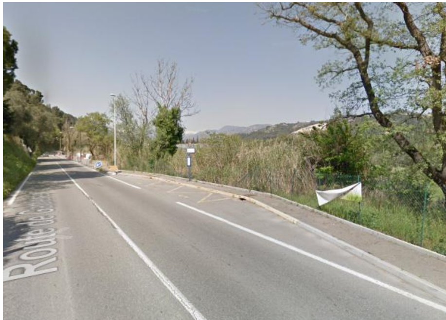
Figure 132 : Arrêt de bus sur la RM2209 (Source : Google Street View)
