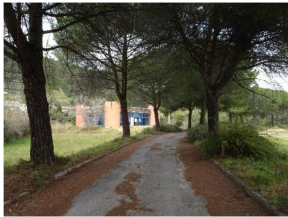
16. Voie d'accès hors d'eau
