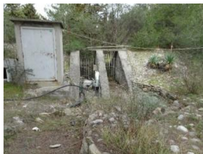
17. Ouvrage hydraulique à travers le merlon
