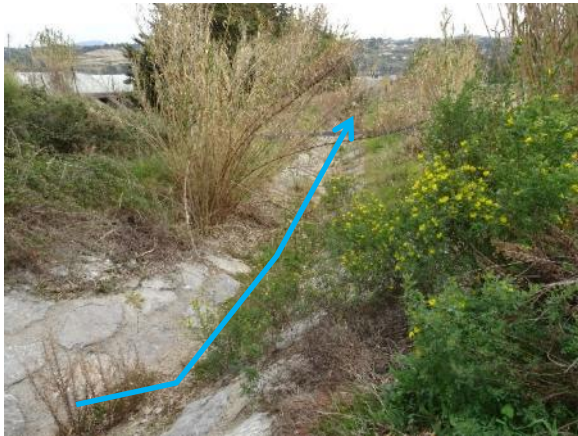
5. Vue vers l'Est depuis le départ du canal depuis le canal des Iscles
