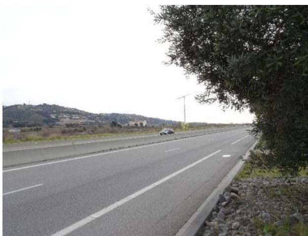
Figure 129 : Vue de la RM6202bis à l'Ouest du site d'étude © EGIS 2019
